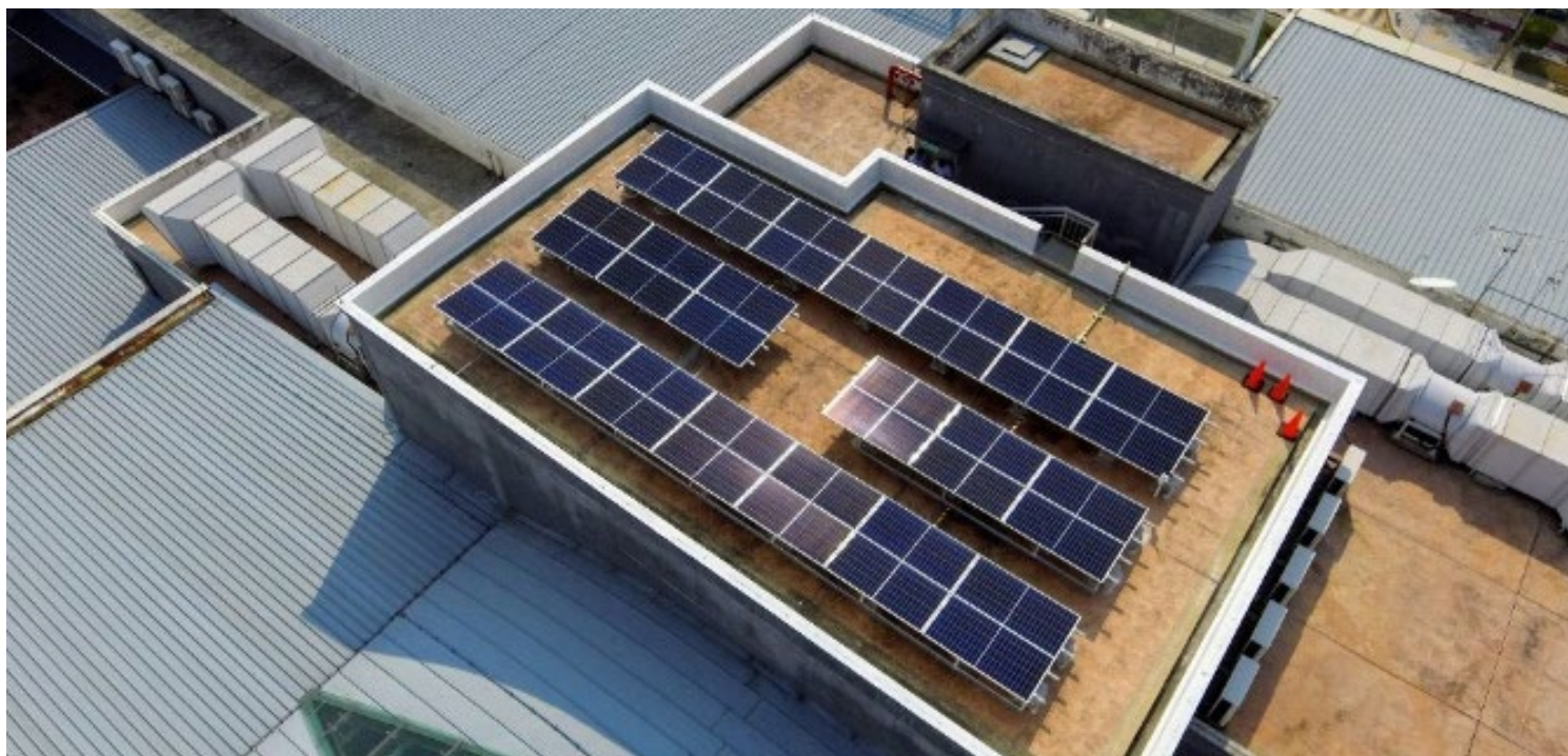
Pandangan dari udara sistem fotovolta suria 16 kW Pihak Berkuasa
