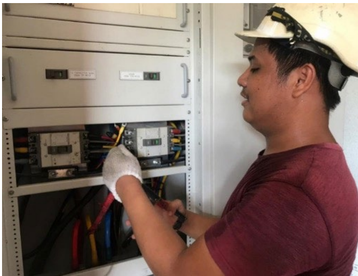
Latihan untuk kursus Pemasangan dan Penyelenggaraan Sistem Fotovolta Suria Tersambung Grid
