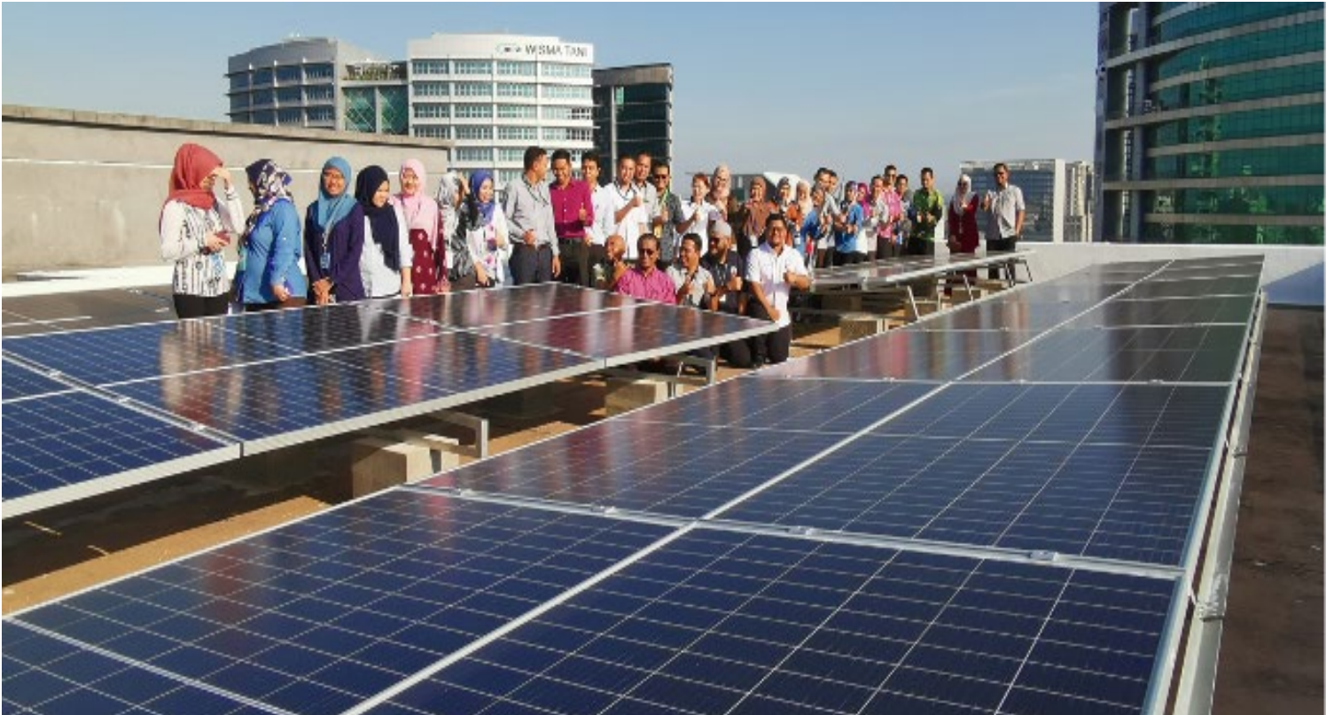
Proses pemasangan oleh kontraktor yang dilantik, ERS Energy Sdn Bhd, sehingga projek sistem fotovolta suria 16kW Pihak Berkuasa siap sepenuhnya
