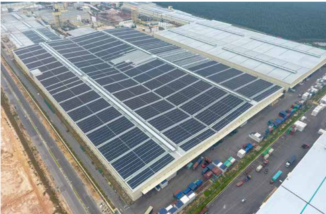
Projek solar PV di atas bumbung terbesar di Malaysia di bawah NEM 2.0 berkapasiti 29.667MWp oleh Xinyi Solar.
